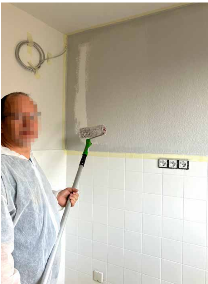
Malerarbeiten benötigen keine Erlaubnis
